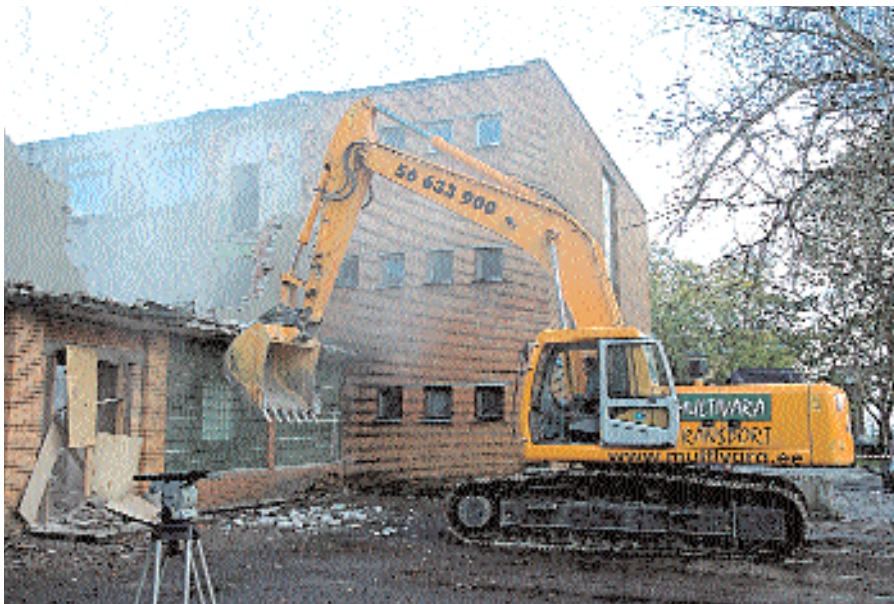
НАЧАЛО СТРОИТЕЛЬСТВА ТЕХНОПАРКА ULEMISTE CITY: Экскаватор ломает здание бывшего завода “Двигатель”.
