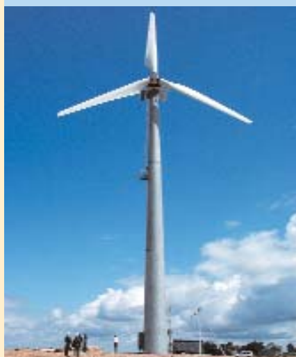
“БОНУС 150”: Размах лопастей в диаметре — 23,8 м, высота — более 30 м.
